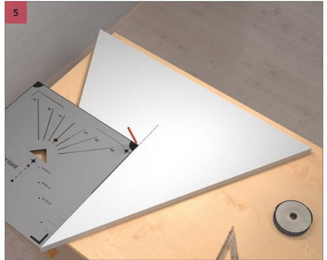
Coloque la plantilla en la esquina inferior de la parte trasera del absorbente mural Rockfon Eclipse y marque las líneas centrales utilizando la esquina de la plantilla. Vea 5 - Resultado.
