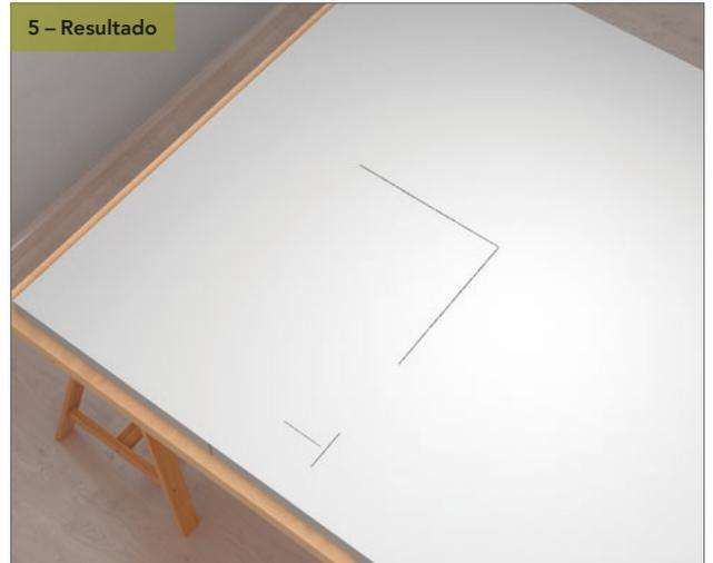
Coloque la plantilla en la esquina inferior izquierda de la parte trasera del absorbente mural Rockfon Eclipse. Con un lápiz, marque las líneas centrales, utilizando la esquina superior derecha de la plantilla y la posición del espaciador. Vea 5 - Resultado.
