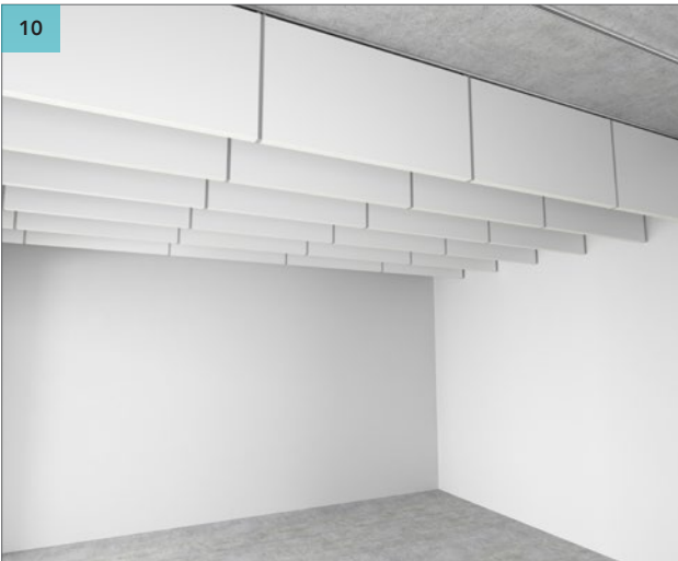
Fije los Rockfon Industrial Baffles restantes a la perfilera T24 y alinéelos utilizando las perforaciones en el extremo de los baffles.
