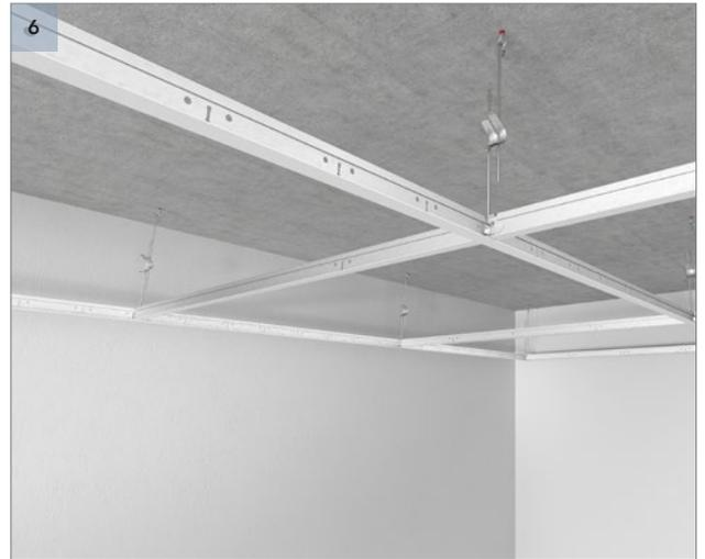
Instale un perfil secundario Click T24 1200 mm en los perfiles primarios cada 1200 mm.
