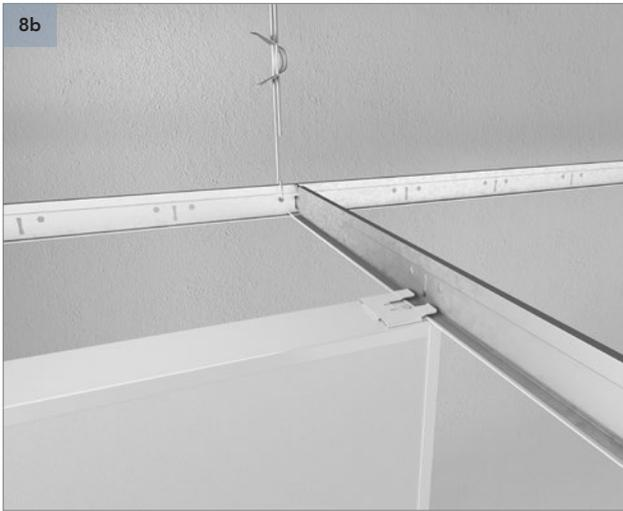
Fije el Rockfon Universal Baffle a la perfilera suspendida T24. Asegúrese de que ambas pestañas queden por encima de la base de la T24. Puede usar las ranuras de los perfiles T24 para alinear los Rockfon Universal Baffles.
