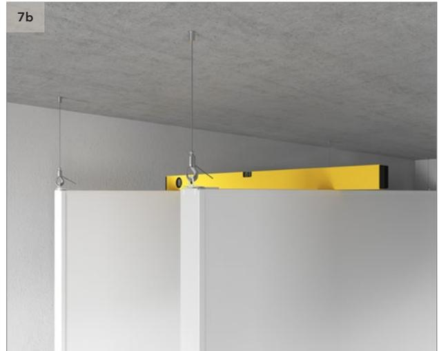
Coloque un nivel en la parte superior o debajo de los baffles para garantizar su uniformidad. La nivelación se puede hacer soltando el bloqueo del gancho y tirando del cable.
