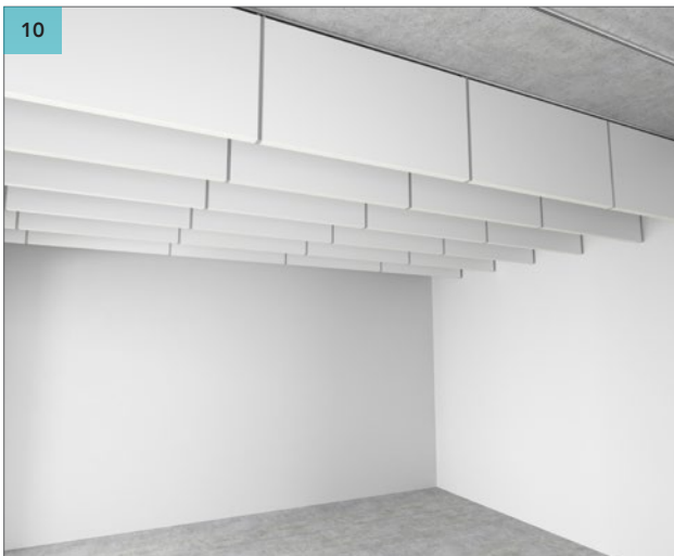
Fije los Rockfon Industrial Baffles restantes a la perfilería T24 y alinéelos utilizando las perforaciones en el extremo de los baffles.
